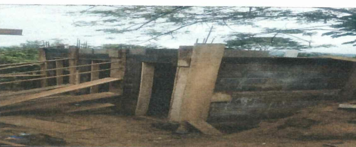
Foto 5: AREA A COLOCAR LA REHABILITACION DE BAÑOS
