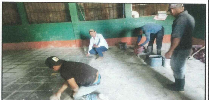
Foto 4: COLOCACIÓN DE PISO CERAMICO ANTIDESLIZANTE PARA TENER UN MAYOR CONFORT EN LA ESCUELA.
