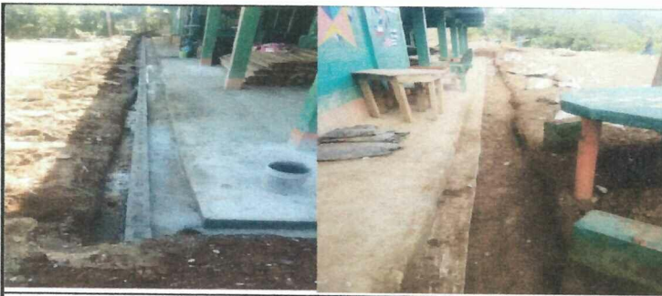
Foto 1: CUNETTA AMPLIADA DE 15 CM A 40 CENTIMETROS DE DIAMETRO-
